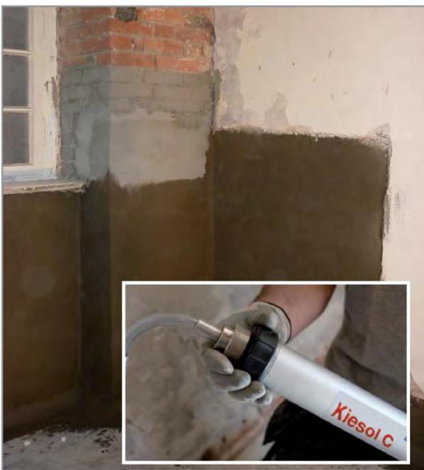
Sperrendes System Kellerinnenabdichtung: Verkieselungsfolgen Kiesol / Sulfatexschlämme / Bohrlochreihe Horizontalsperre.
