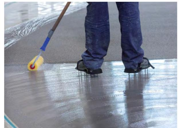
Die applizierte Klebeschicht aus Epoxy UV 100 TX wird mit einer Strukturwalze im Kreuzgang durchgearbeitet.
