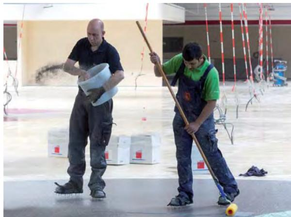
Sofort im Anschluss erfolgt die vollsattige Abstreumung mit Sedimentflocken.
