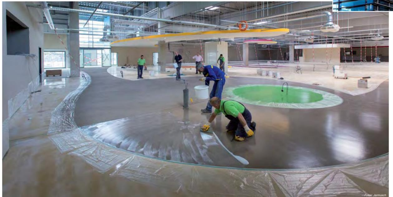
Aufbringen der „Klebeschicht“. Für eine 100%ige Deckfähigkeit der unterschiedlichen Flockenfarben wurden die einzelnen Designs im Grundton der Flockeneinstreuung mit Epoxy BS 3000 SG farbig gestaltet.
